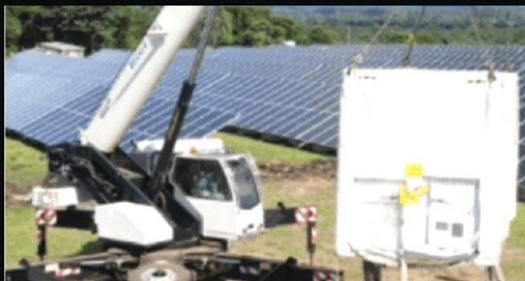
El All-in-One llega armado a la obra
