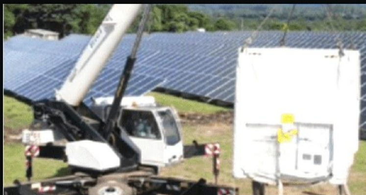
El All-in-One llega armado a la obra
